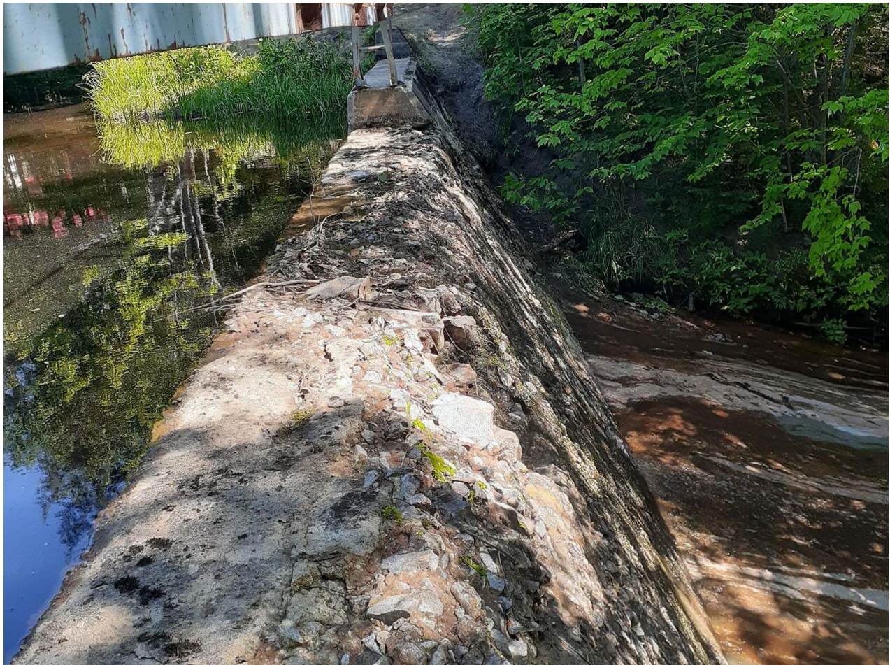
Figure 12 - Débit passant par-dessus le barrage le 17-06-2020
