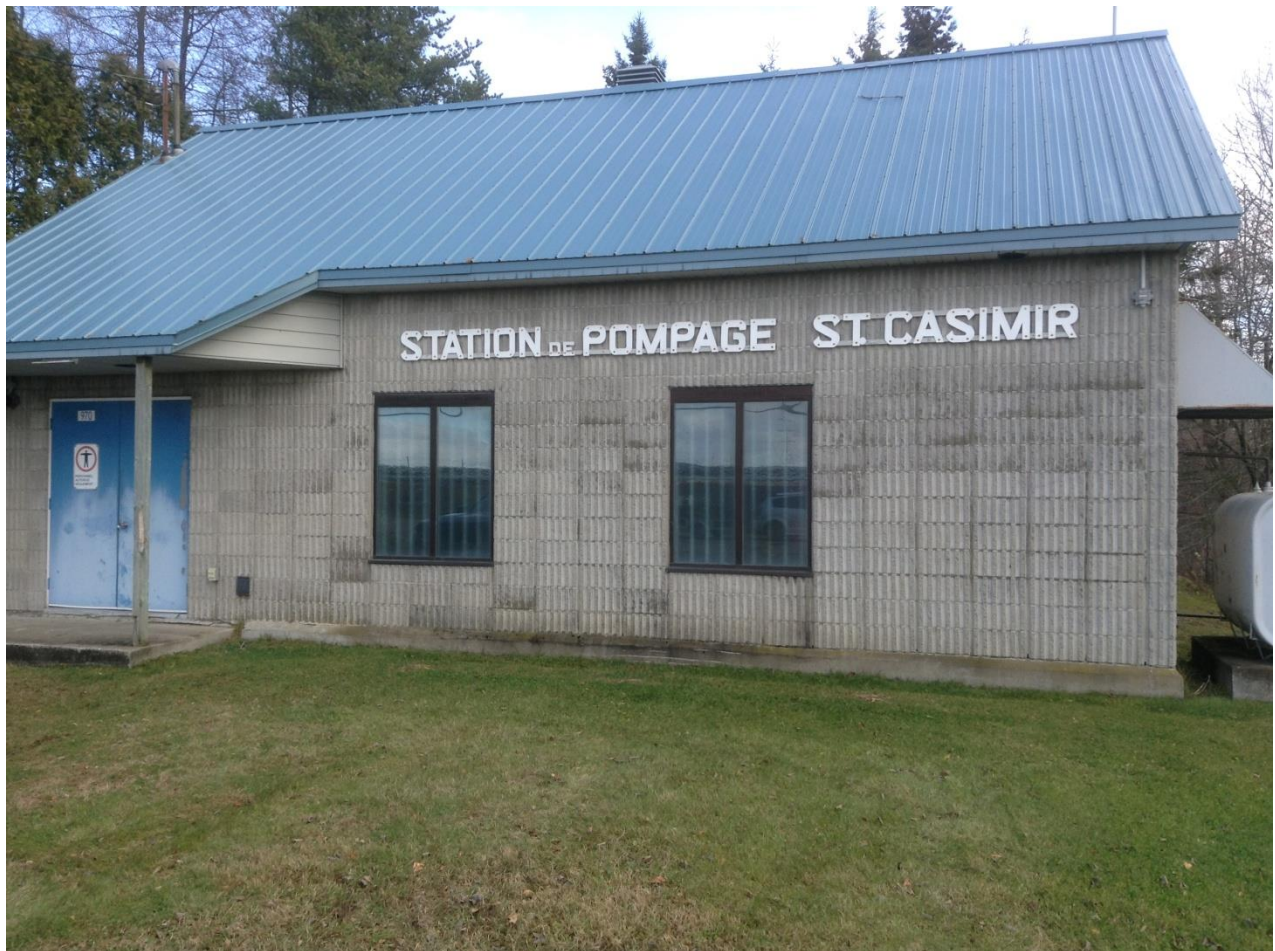
Figure 2 - Station de pompage (réservoirs + chloration)
