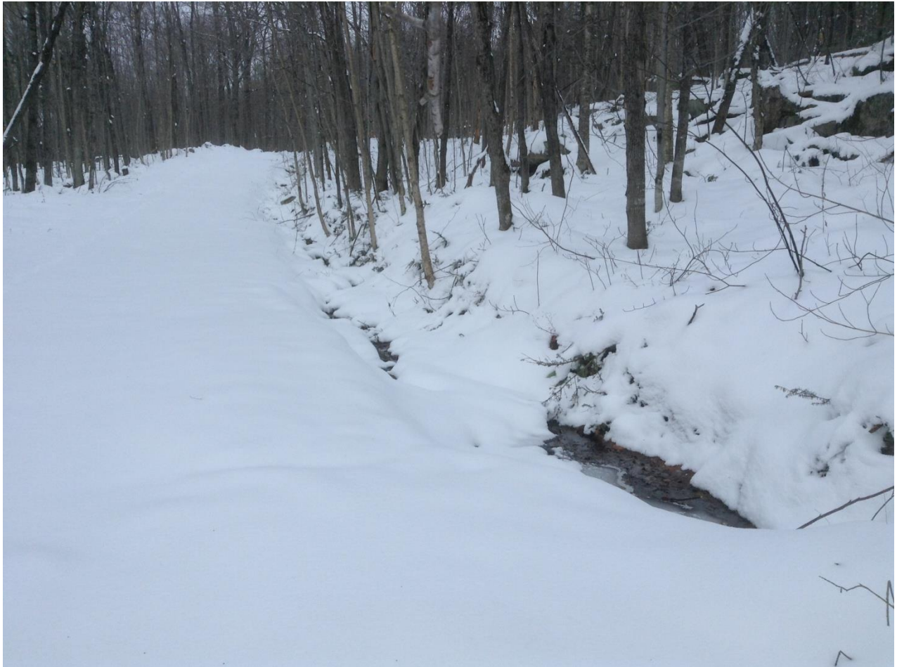
Figure 8 - Fossé du chemin donnant accès au barrage Niagarette-2
