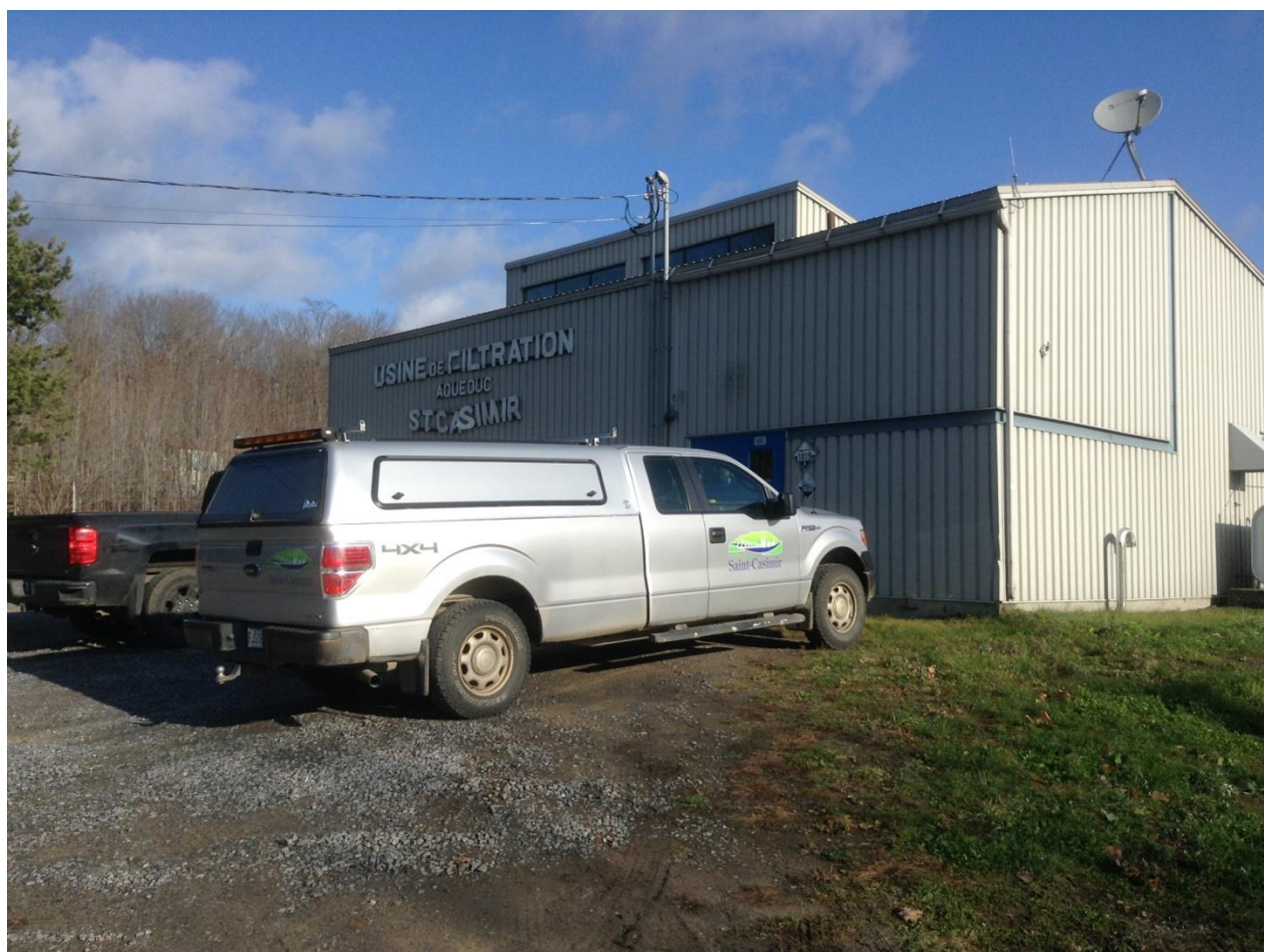
Figure 5 - Installation de production d'eau potable Saint-Casimir
