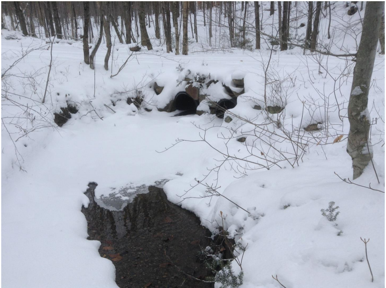
Figure 10 - Ponceaux parallèles à moins d'un mètre d'espacement
