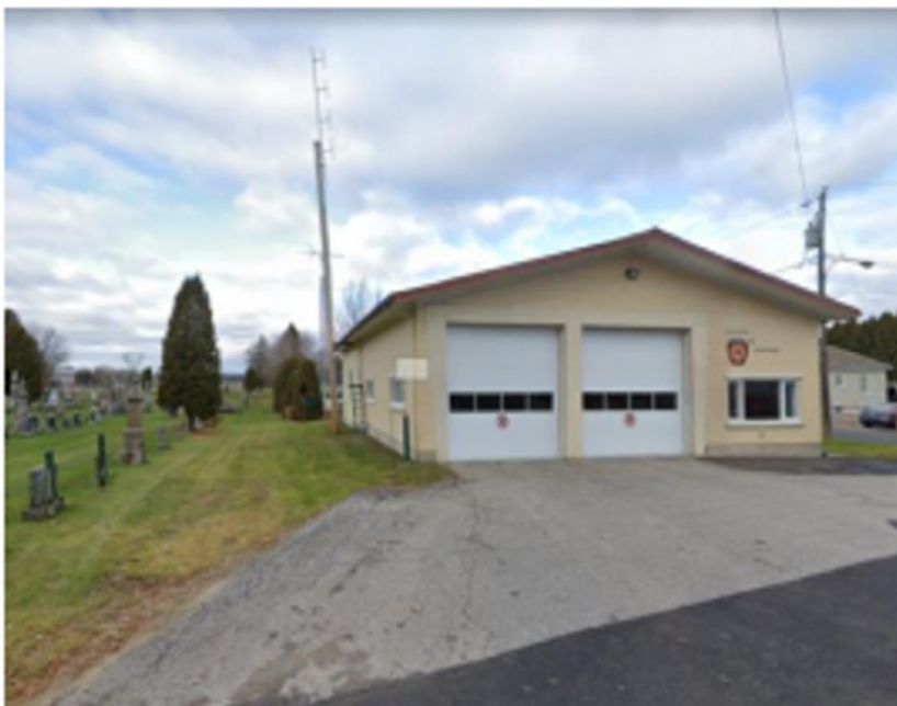
Caserne existante, vue générale avec cimetière
