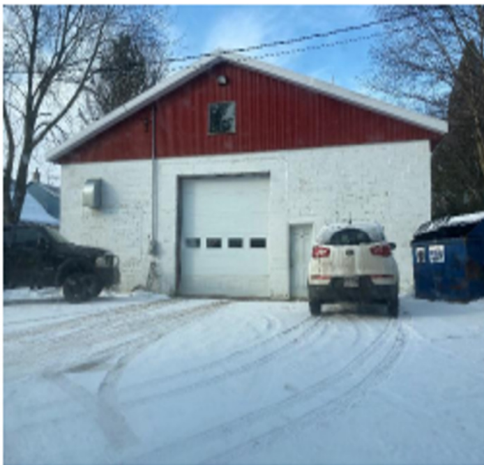
Façade principale du garage existant
