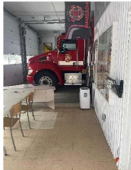
Accueil et espace de repos non conformes, à même l'espace ouvert du garage
