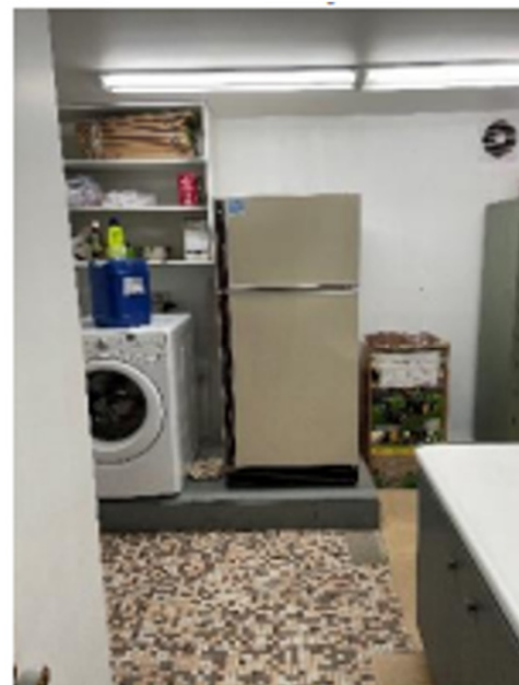
Aire de nettoyage des EPI non exclusivement dédiée, ne répondant pas aux normes (présence du réfrigérateur)
